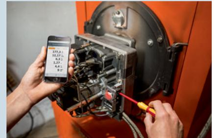
**Solución:** Medición de la pérdida de gases de combustión y los valores de emisión (CO, CO<sub>2</sub>) y, en dado caso, la definición de la necesidad de trabajos de mantenimiento.
