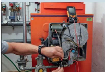
**Solución:** Comprobación de la corriente de ionización con un multímetro certificado.
