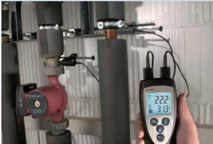
**Solución:** Medición de la temperatura de alimentación y de retorno como preparación del ajuste hidráulico.
