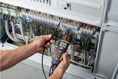
**Solución:** Medición de corriente y tensión en el armario de distribución, en instalaciones de bombas de calor, compresores e instalaciones de climatización. **testo 750, testo 755, testo 760, testo 770**
